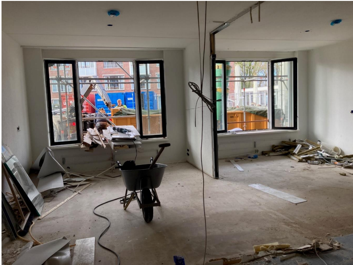
Het leegruimen en breken van de vier appartementen die omgebouwd worden tot huiskamer.
