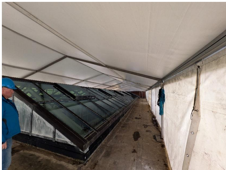
Er is een tijdelijk dak over het dak van het atrium geplaatst, zodat deze verwijderd kan worden.
