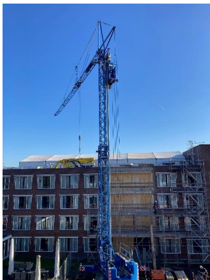
Er is een tijdelijk dak over het dak van het atrium geplaatst, zodat deze verwijderd kan worden.
