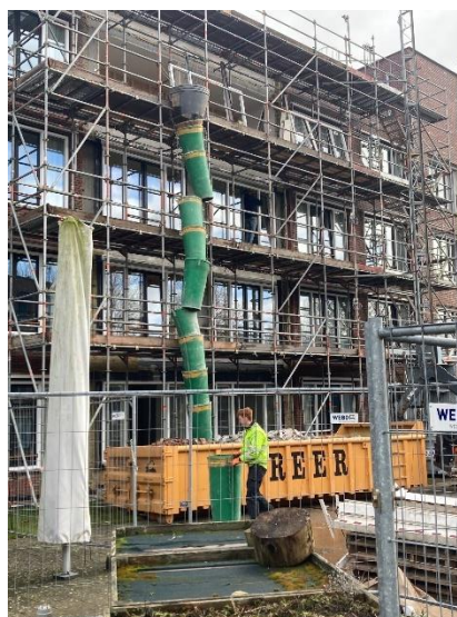
De buitenkant in de steigers
